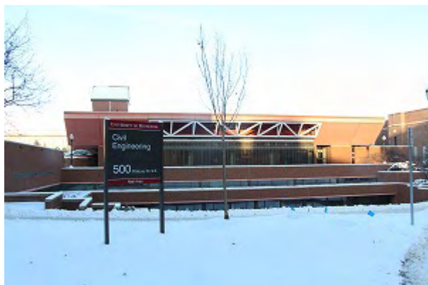
写真 1 土木工学専攻の建物
