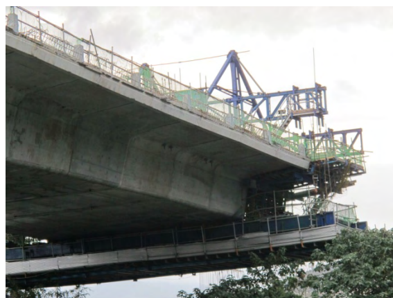
写真 8 張出し架設中の PC 箱桁
