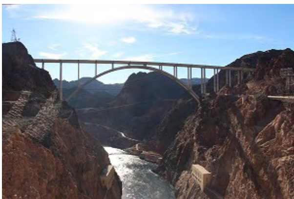
写真 9 コロラドリバー橋（フーバーダム）
