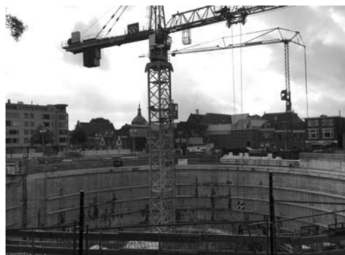
地下駐車場の工事の様子
