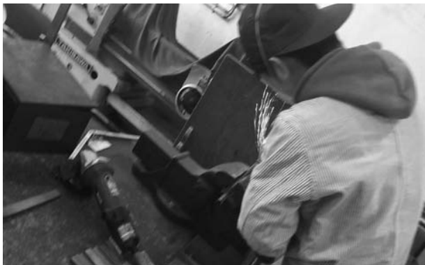
グラインダーでの施工
