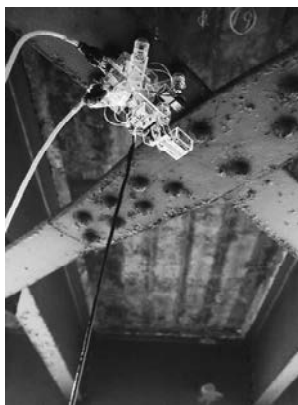
点検中の様子
