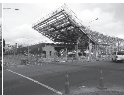
図 14 建設中の建物
