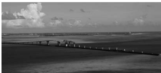
沖縄離島橋梁の全景
