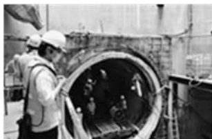
写真17 トンネル端部
