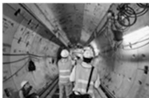
写真18 トンネル内部
