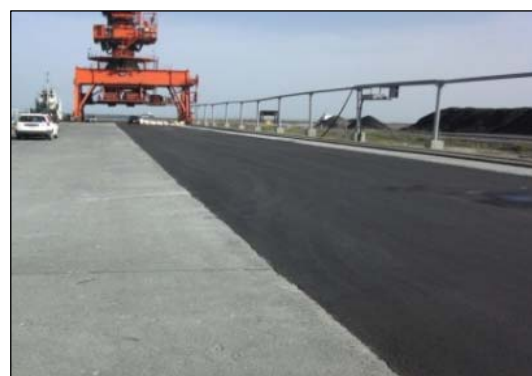
アスファルト舗装で応急補修
