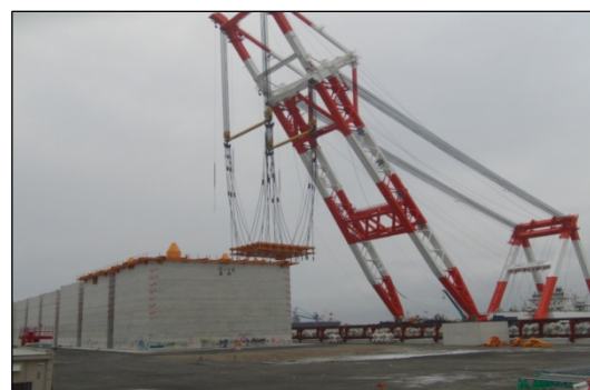
大型起重機船によるケーソン進水
