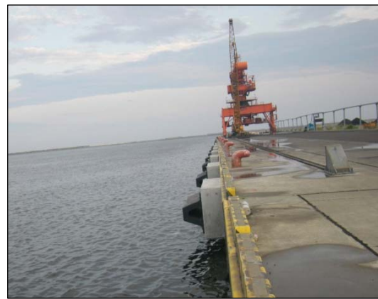
台座により防舷材前面を調整
