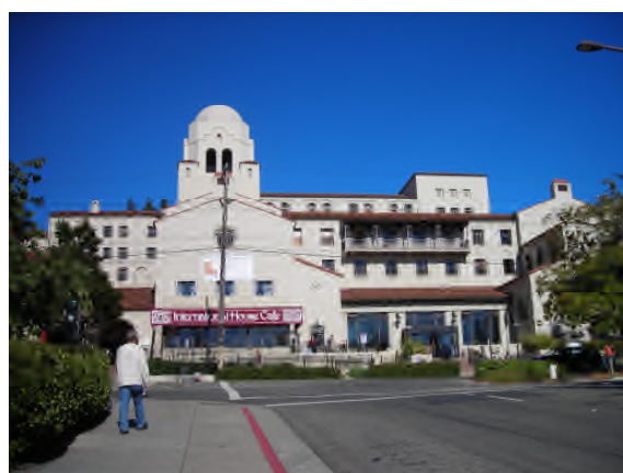
写真2 寮(International house)の外観
