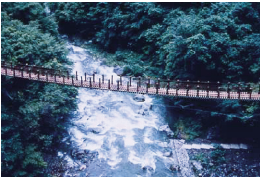
樅の木吊橋（土木学会田中賞（作品部門））
